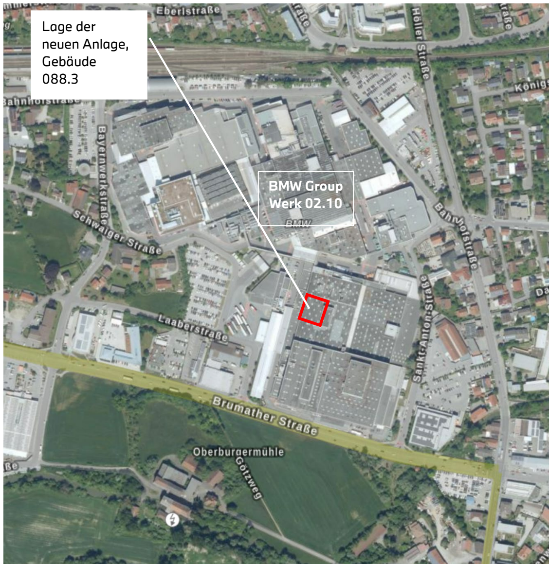
Abbildung 6: Luftbild BMW Group Werk 02.10 (Quelle: BayernAtlas) mit Lage der neuen Anlage im roten Quadrat
