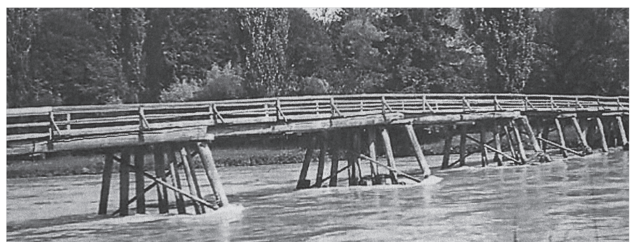
Die hölzerne Isarbrücke, die am 29. April 1945 von deutschen Truppen gesprengt wurde.
