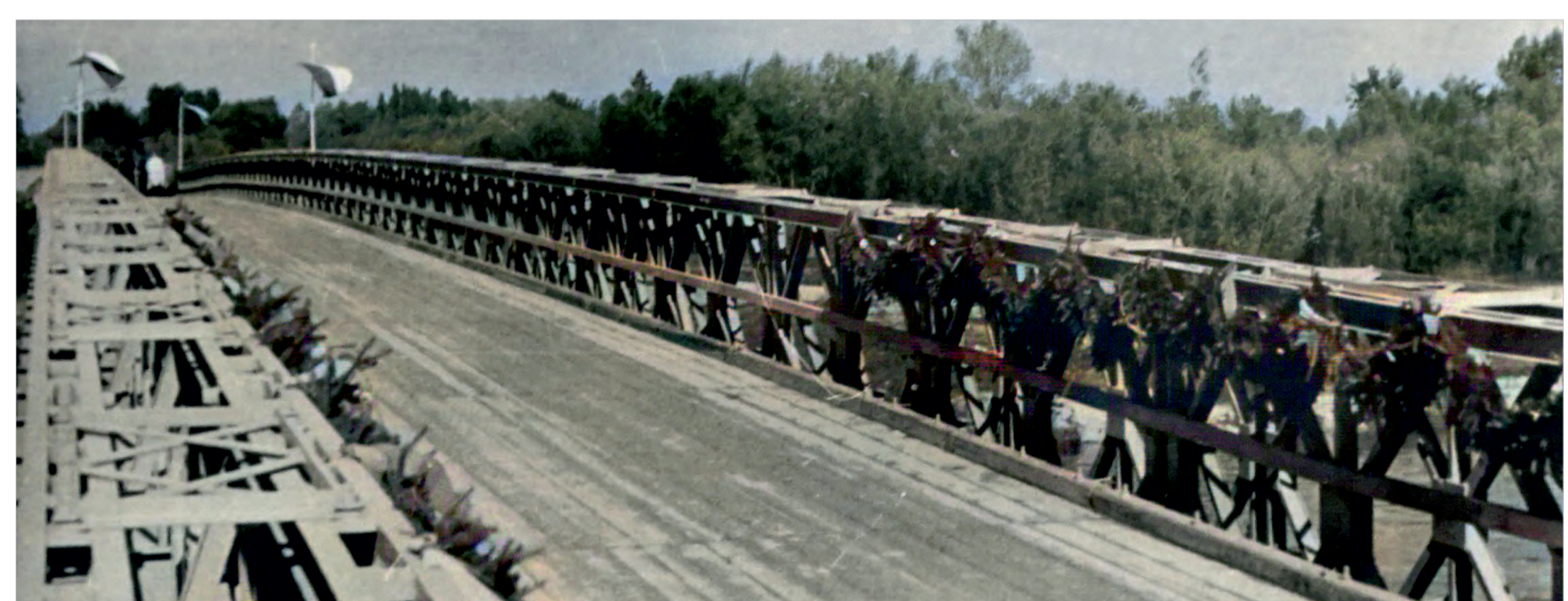
Die Notlösung aus dem Jahr 1952: eine Bailey-Brücke mit einer Tragkraft von 3 Tonnen.
