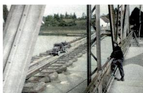
Der Verkehr läuft einspurig über die Pontonbrücke, die auf Schlauchbooten verlegt ist. Die ursprüngliche Isarbrücke ist im hinteren Teil zerstört.
