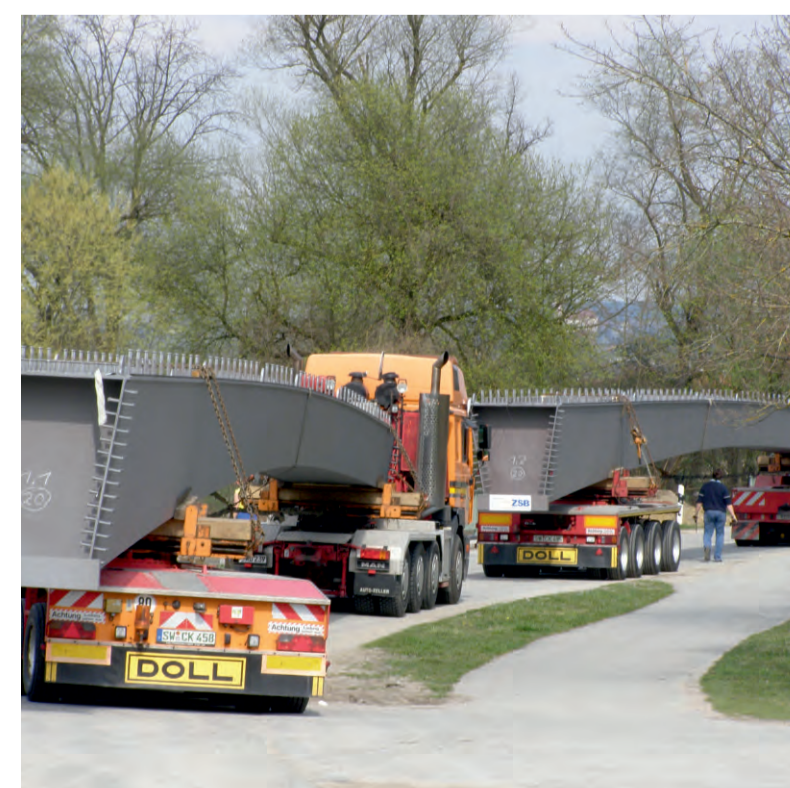
Ein Schwertransport liefert die 40 Tonnen schweren Stahlhohlkästen für die Unterkonstruktion der Brücke.
