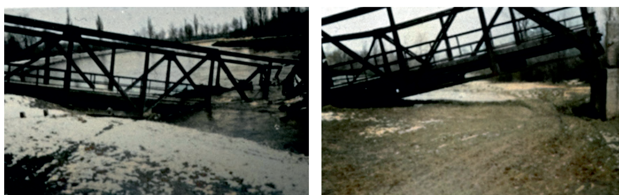
29. April 1945: Die zerstörte Isarbrücke
