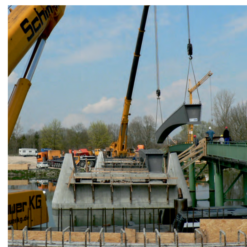
Setzen der Stahlhohlkästen auf die Betonpfeiler.
