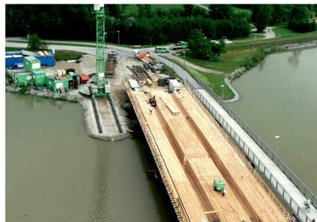
Die neue Brücke nimmt Gestalt an: Die Schalung der neuen Brücke steht.
