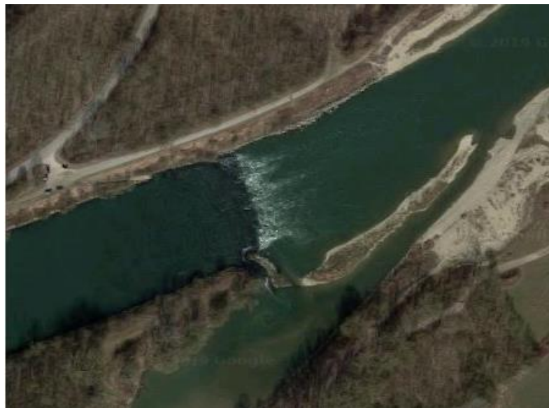
Abbildung 6: Sohlschwelle, flussabwärts des Kraftwerks.
