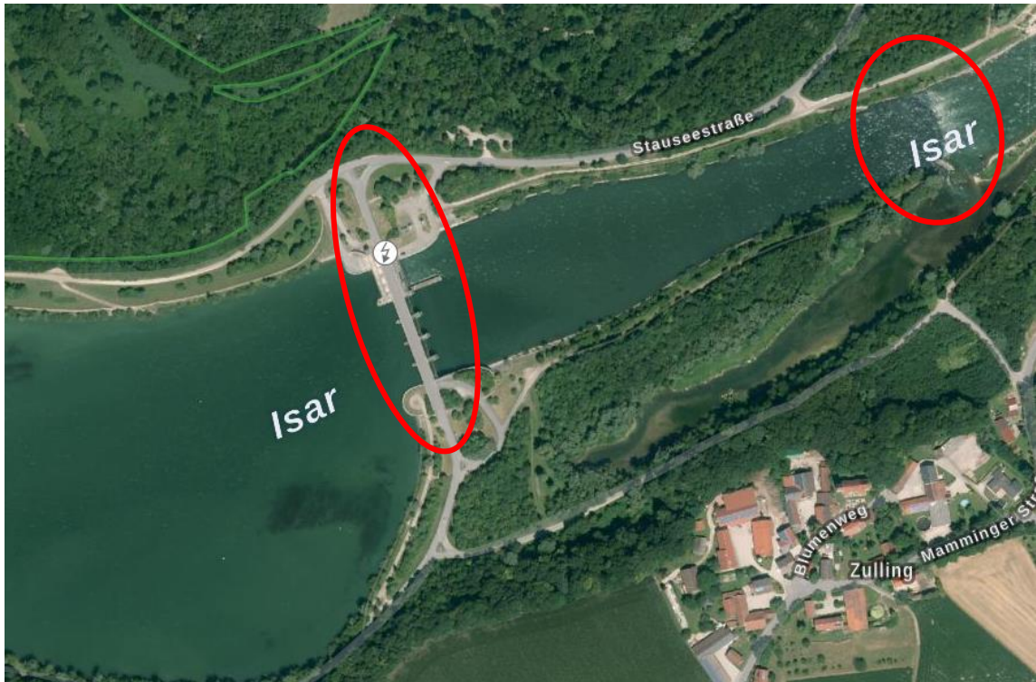
Abbildung 2: Staustufe Landau mit Sohlschwelle im Unterwasser (Quelle: BayernAtlas)
