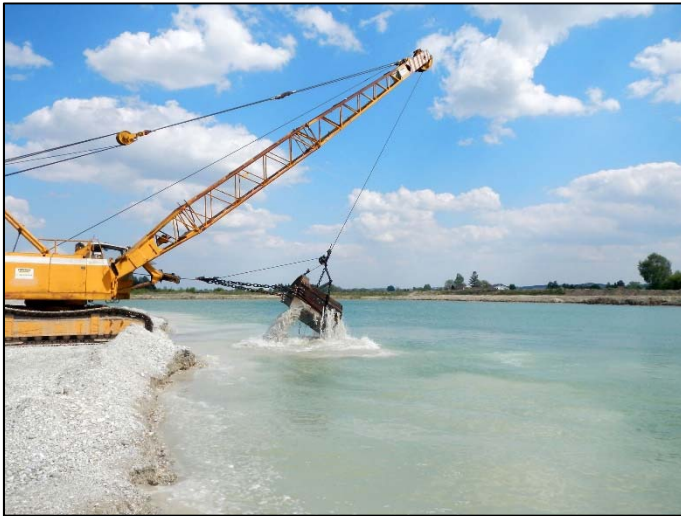
Abbildung 14: Hochheben des Schürfkübel
