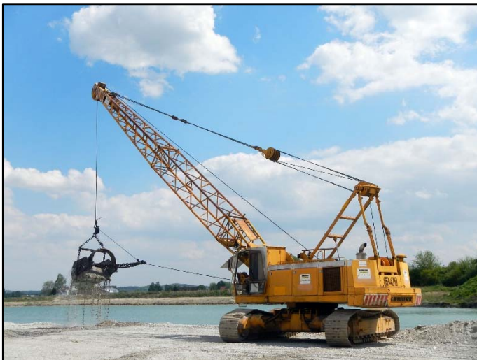
Abbildung 15: Drehen des Baggers mit dem Schürfkübel
