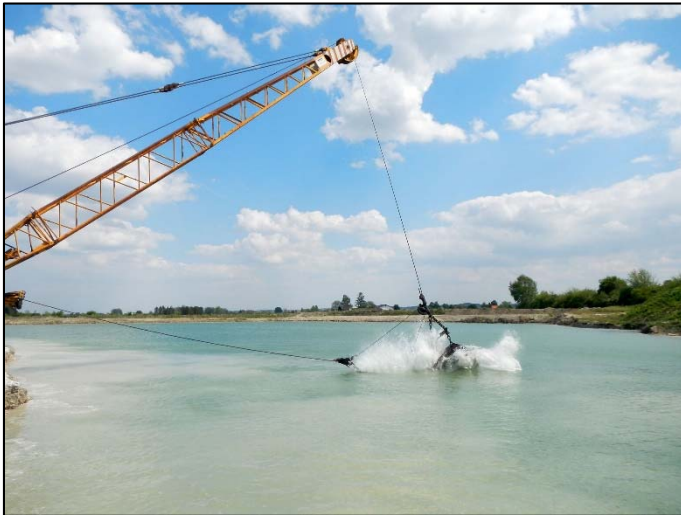
Abbildung 12: Auswerfen des Schürfkübels in den Weiher
