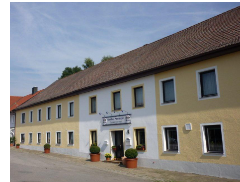
Gasthaus Neumayer- Stömmer Mettenhausen
