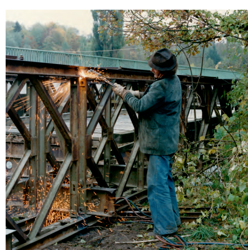
Manueller Abbau der alten Eisenbrücke. Der wertvolle Rohstoff wurde recycelt.
