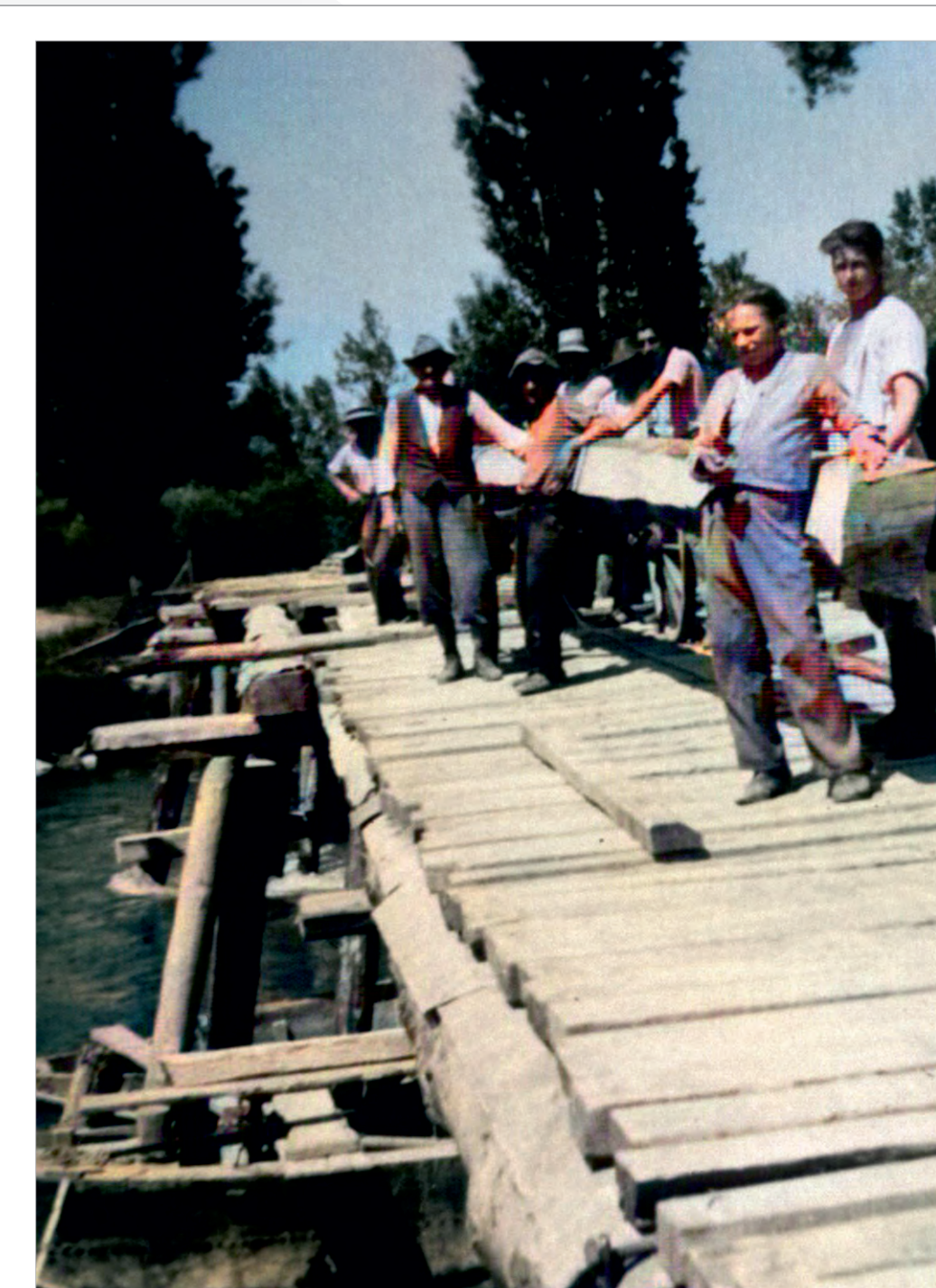
Wiederaufbau der Holzbrücke nach dem Eisstoß war Aufgabe der Gemeinde auf eigene Kosten.
