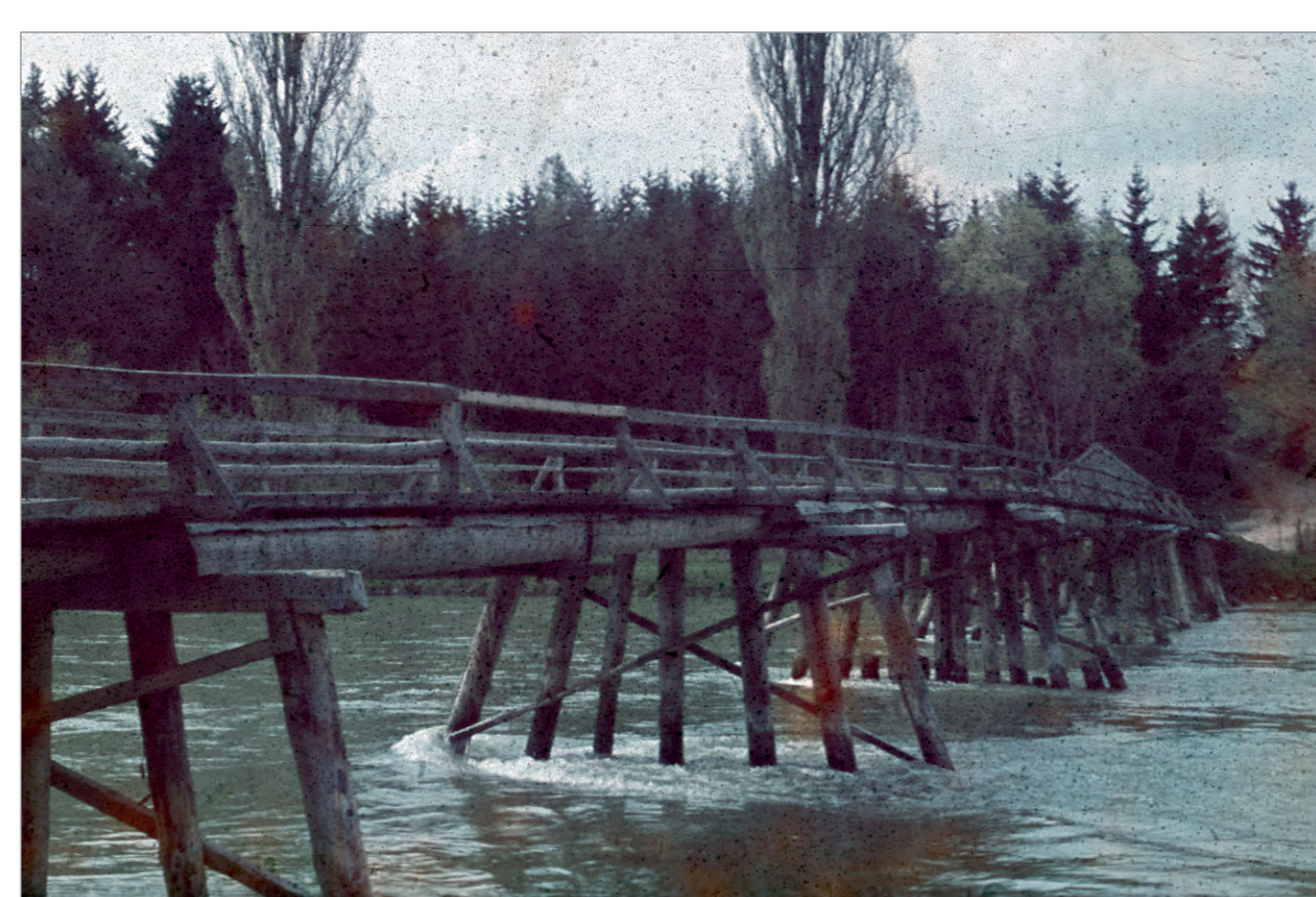
Die hölzerne Isarbrücke wurde 1900 errichtet.
