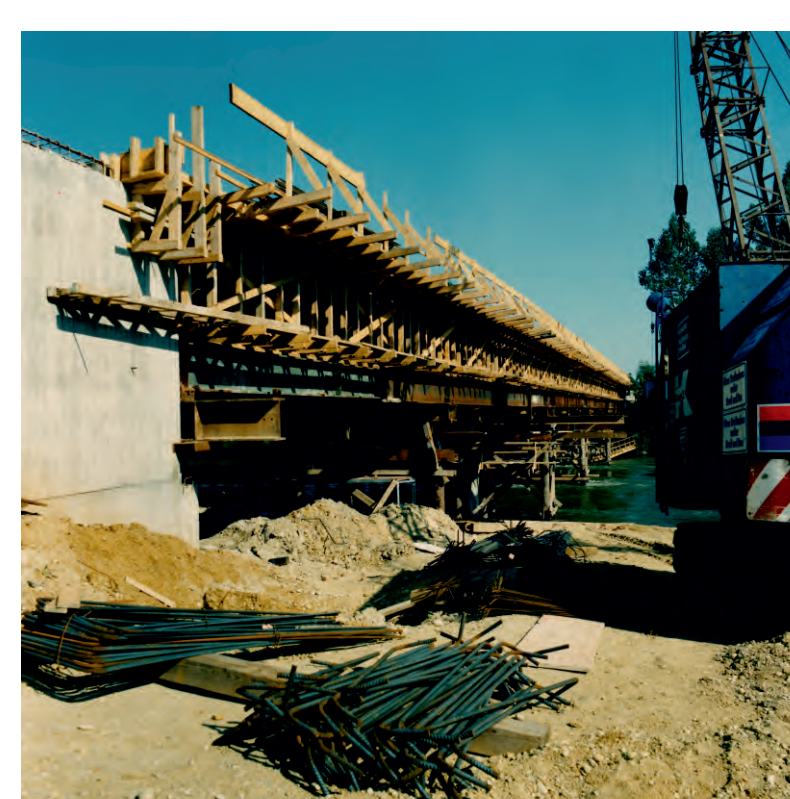
Schalungsbau für die neue Brücke.
