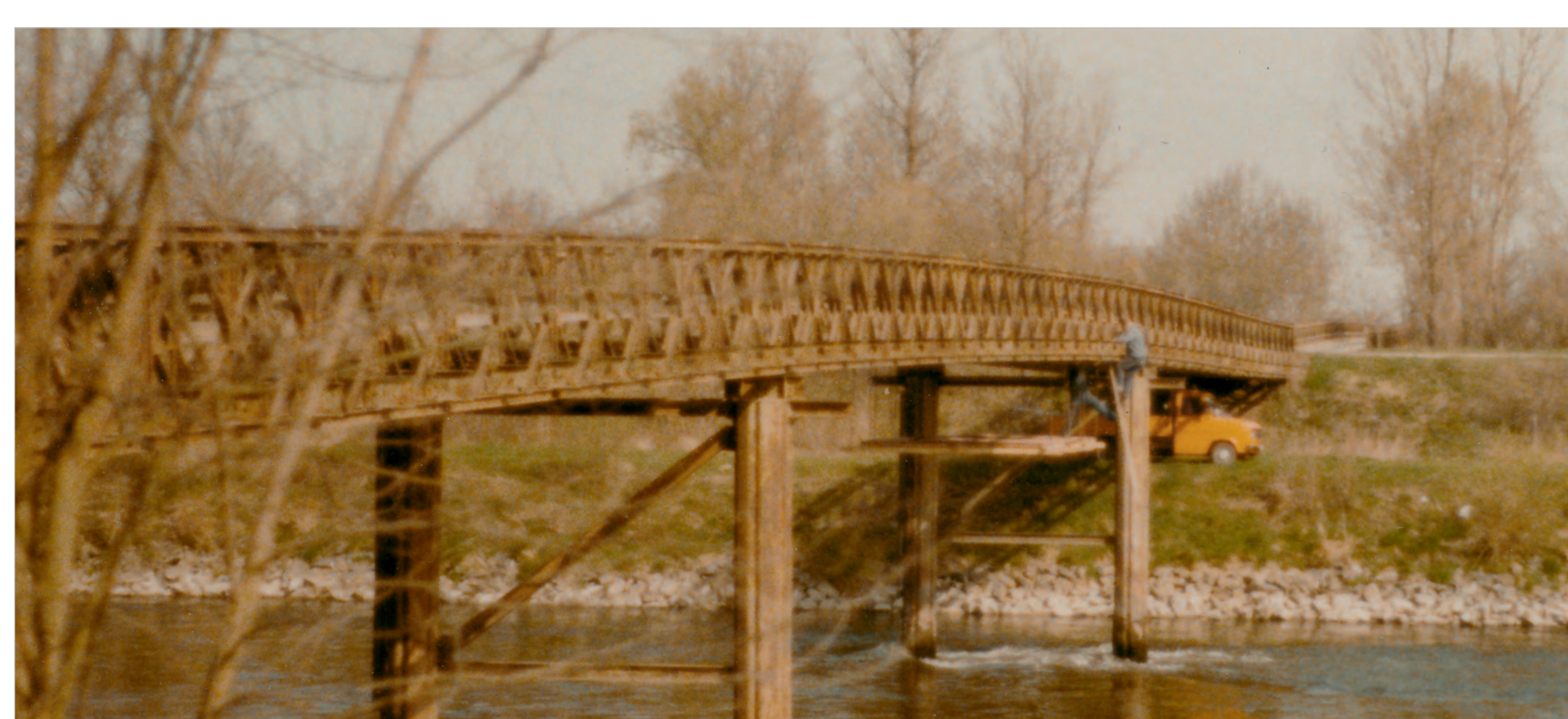
Die Bailey-Brücke von 1951 hatte eine Traglast von 12 Tonnen und konnte nur einspurig befahren werden.
