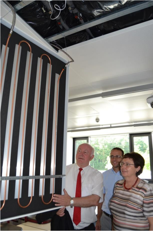
Landrat Heinrich Trapp mit Armin Grassinger von der Abteilung Hochbau und Schulleiterin Angelika Wallner in einem der Klassenräume, die mit der modernen Technik ausgestattet wurden. Zu Demonstrationszwecken wurde ein Element der Kühldecke ausgehängt.
