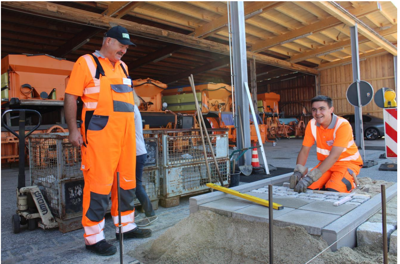
Erwin Breitschopf und Auszubildender Florian Humburg bei Pflasterarbeiten.
