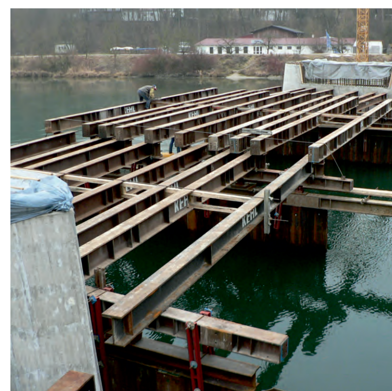
Unterkonstruktion und die massiven Pfeiler der neuen Brücke.
