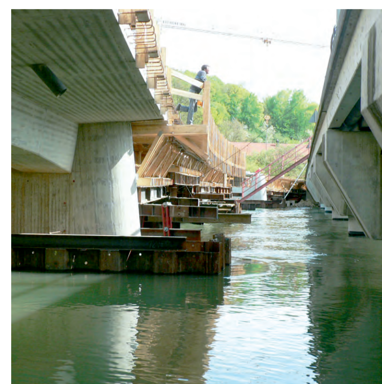
Dank einem parallelen Neubau zur alten Brücke konnte diese noch benutzt und eine monatelange Umleitung vermieden werden.
