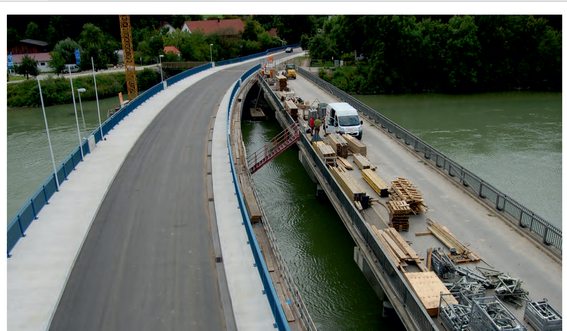
Die alte Brücke (rechts) kurz vor dem Abbruch (rechts).
